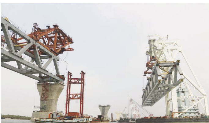
2月20日,在孟加拉国帕德玛大桥项目工地,中国建造的万吨级中心架梁起吊船“天一号”准备将总重超过3000吨的钢架梁放到桥墩上。新华社发 (段永红 摄)
