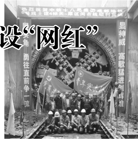
中铁十八局集团四公司承建的成都地铁六号线4标天宇路站~犀浦站盾构区间右线顺利贯通。刘超 周全长 摄
