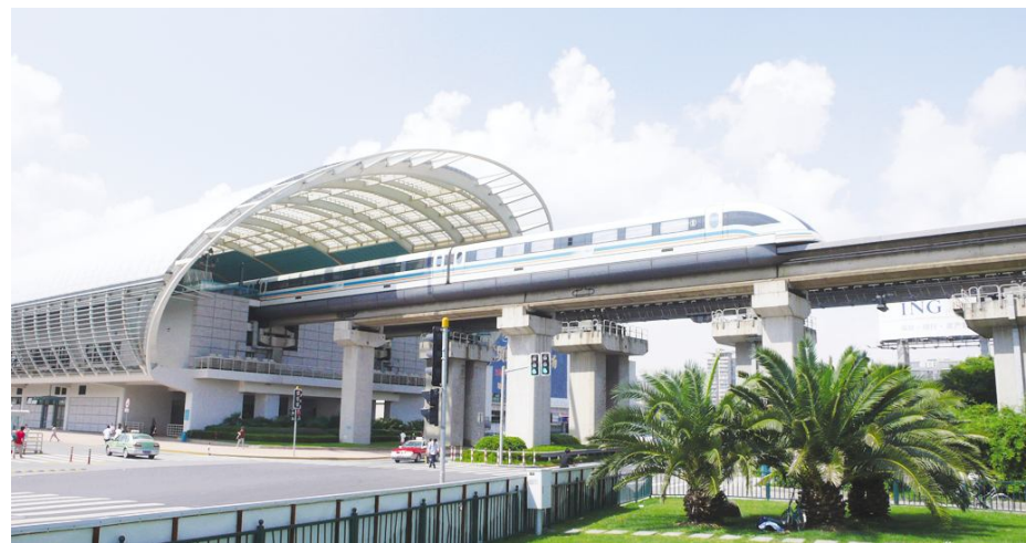
● 世界首条商业运营磁悬浮——上海磁悬浮采用23局生产的高精度磁悬浮轨道梁,梁体施工精度要求控制在1mm,获国家科技进步奖及7项国家专利。
