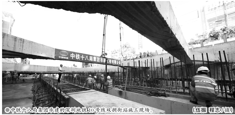
○中铁十八局集团承建的深圳地铁10号线双拥街站施工现场。(伍振 程志/摄)
