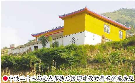
●中铁二十三局定点帮扶后协调建设的彝家新寨房屋
