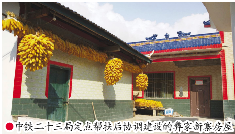
●中铁二十三局定点帮扶后协调建设的彝家新寨房屋
