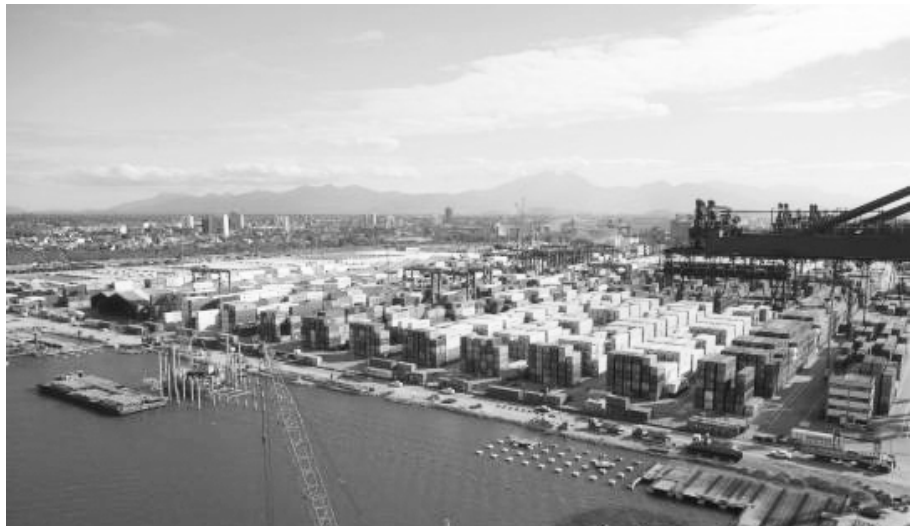
巴西巴拉那瓜港TCP码头现有的集装箱堆场。
