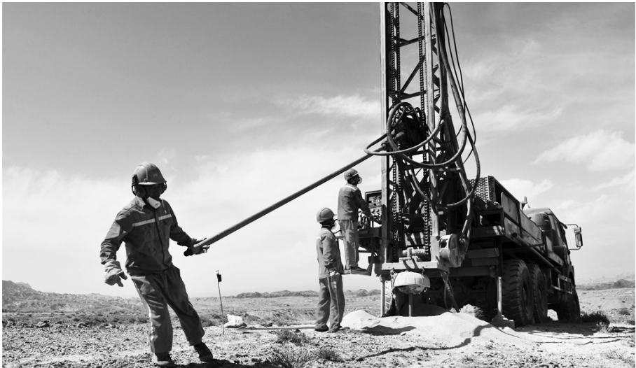
大功率铁马钻在戈壁砾石区施工作业, 每天可钻 10 多口 20 多米深的炮井。(王智 摄)
