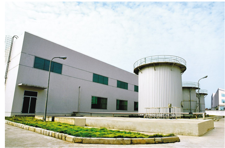
● 保健酒生产基地污水处理站
