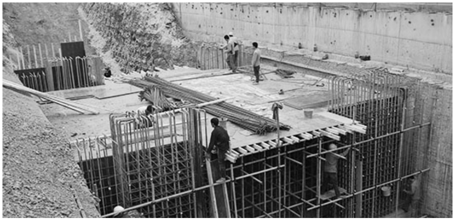
●兴文石海站加快施工
