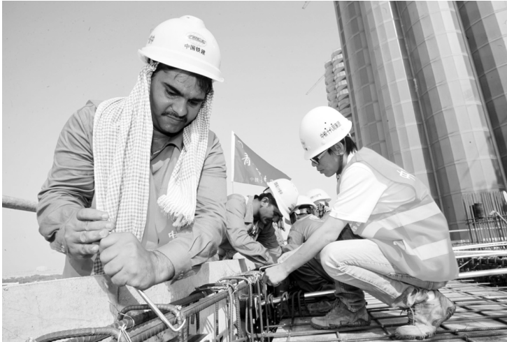
中国铁建十八局集团国际公司迪拜公司卡塔尔分公司建设者在绿洲酒店精心绑扎钢筋。
