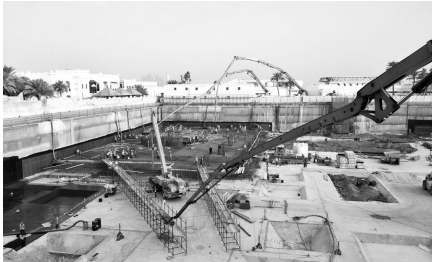
中国铁建十八局集团国际公司迪拜公司卡塔尔分公司建设者在绿洲酒店进行筏板、塔吊基础和挡土墙施工。(伍振 杨国辉 摄)
