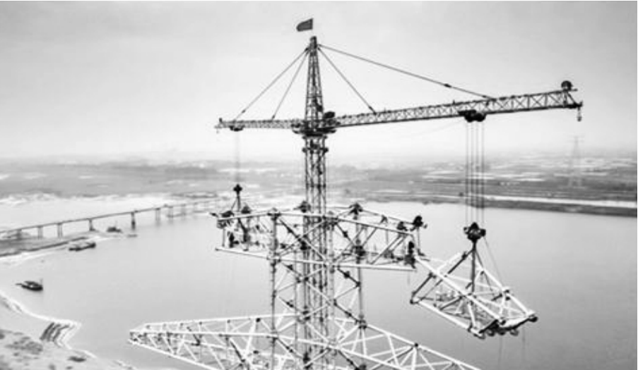
●图为国家电网员工在湖北省潜水县巴河畔高空吊装跨河铁塔。
