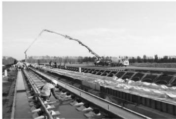
● 图为正在建设中的京沈高铁辽宁段路基无砟轨道无缝线路铺轨现场。
