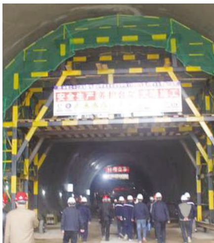
图为“铁路隧道新型防排水系统及工法工艺”试用现场观摩会
