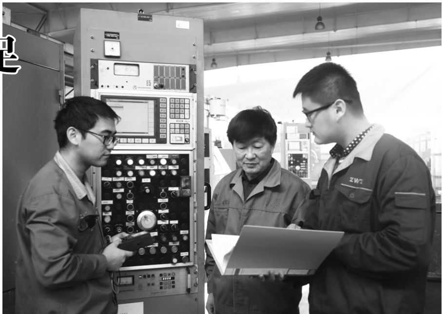
●孙盛桐(中)和徒弟一起检修设备。
