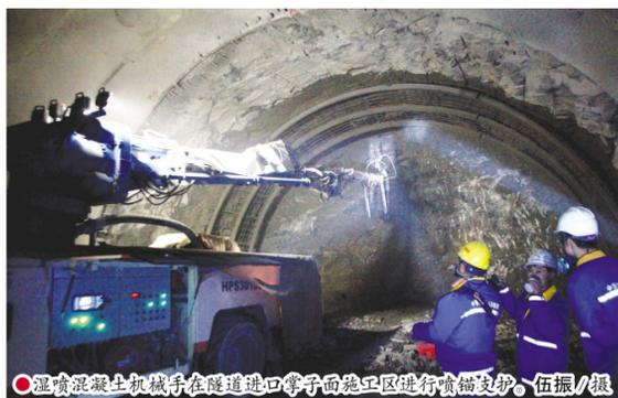
●湿喷混凝土机械手在隧道进口掌子面施工区进行喷锚支护。伍振/摄
