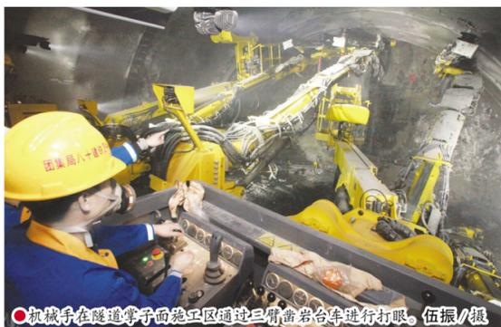
●机械手在隧道掌子面施工区通过三臂凿岩台车进行打眼。伍振/摄
