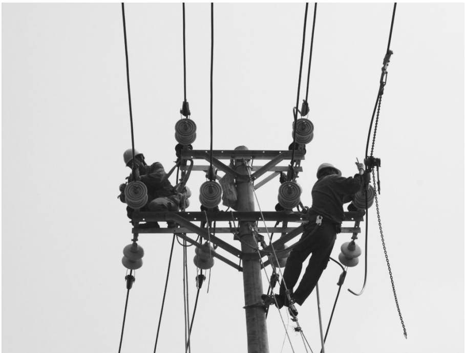
国网永川供电公司施工现场
