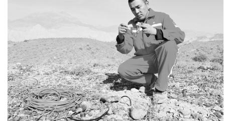
●采集工序质量管理人员检查检波器埋置情况，核对物理点桩号。
