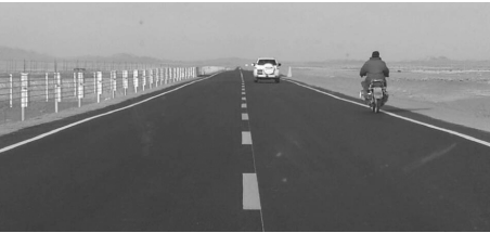
● 在戈壁滩上建成的新疆三鸣高速公路开通运营
