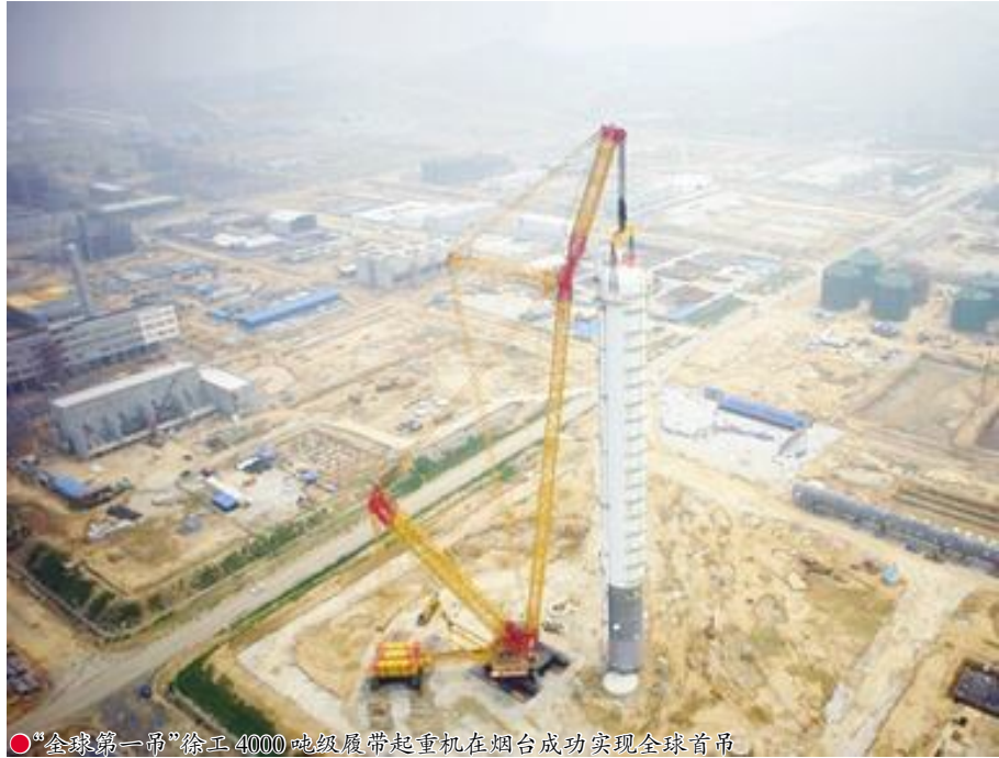
“全球第一吊”徐工4000吨级履带起重机在烟台成功实现全球首吊
