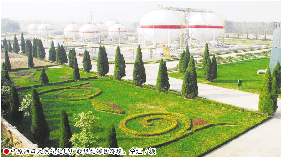
●中原油田天然气处理厂轻烃站罐区环境。全江/摄
