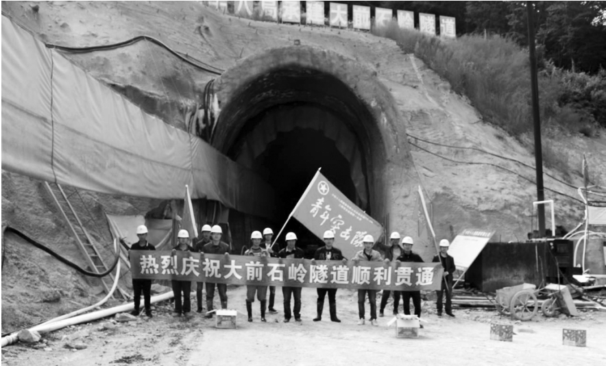
● 田桓铁路大前石岭隧道贯通现场
