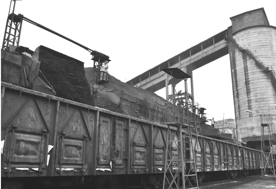
图为代池坝矿业生产的煤炭正通过火车运输发往客户
