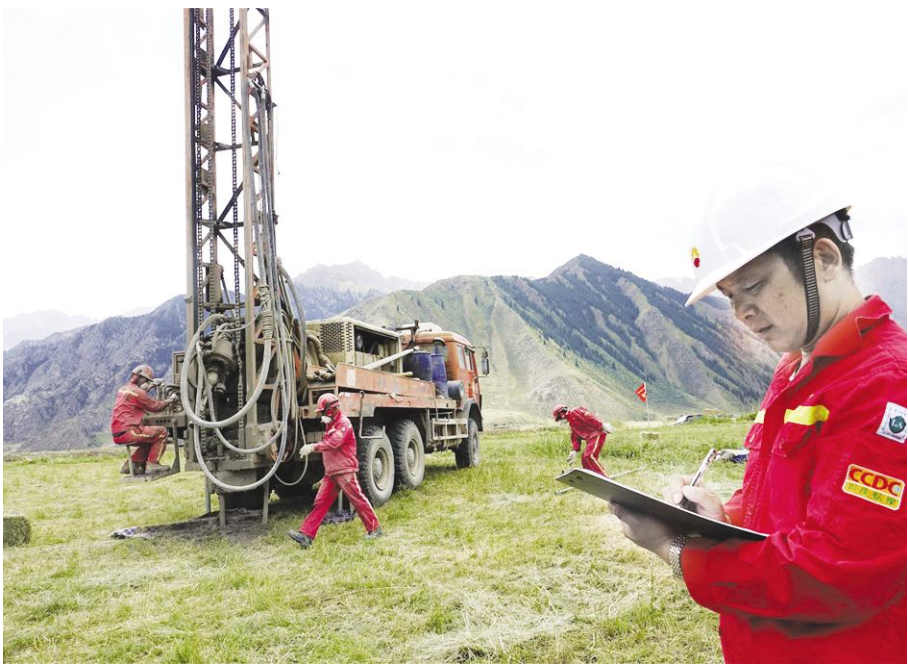
安全管理人员作业现场做检查记录
