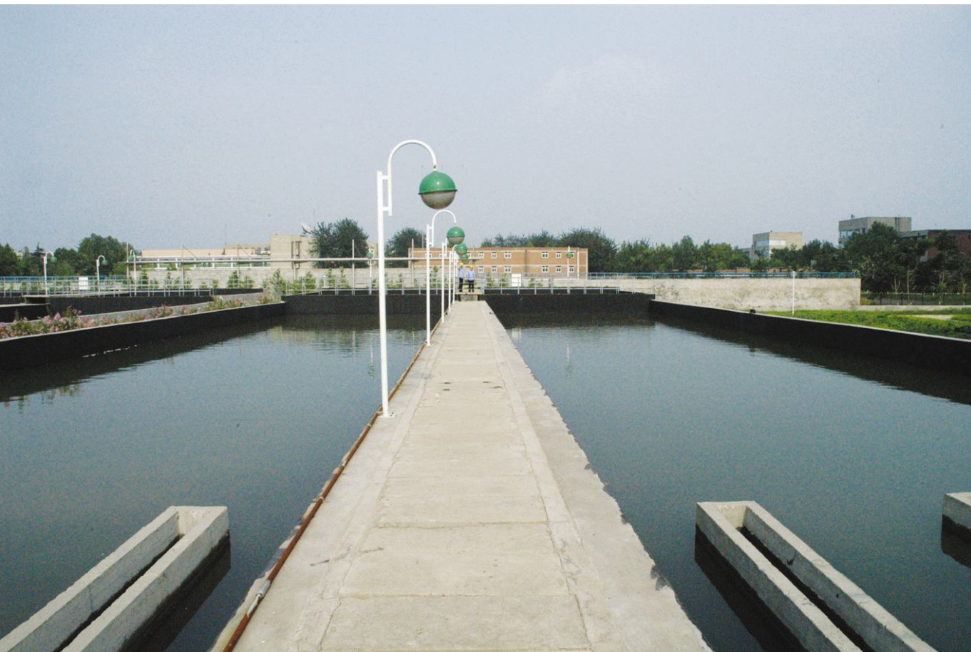
●沙河电厂建设配套节水工程,年可节水 1000 万立方米。
