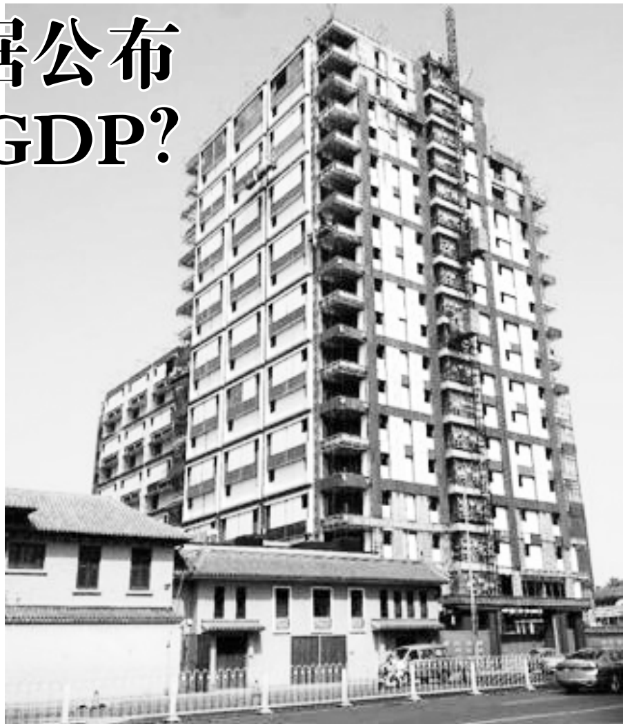
● 北京一处正在建设的楼房
