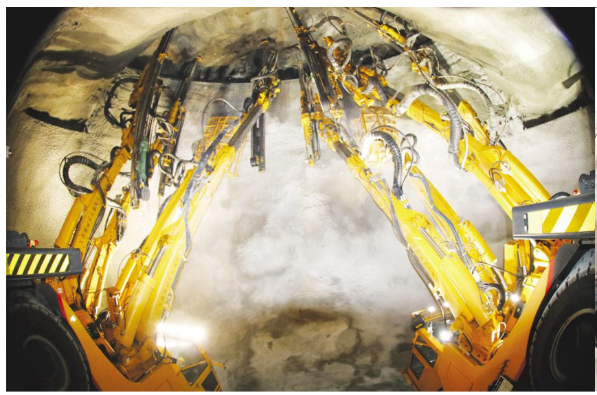
●7月12日,两台全智能三臂凿岩台车在掘进施工。
