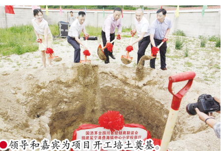
领导和嘉宾为项目开工培土奠基。
