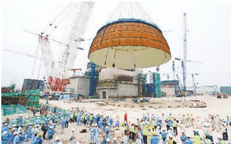
●5 月 25 日,“华龙一号”核电站全球首堆示范工程福建福清核电 5 号机组完成穹顶吊装,标志着该工程从土建施工阶段全面转入设备安装阶段。新华社记者 姜克红 摄
