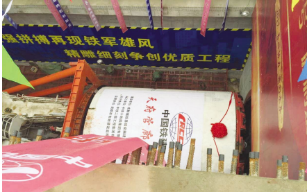
●天府管廊 1 号盾构机
