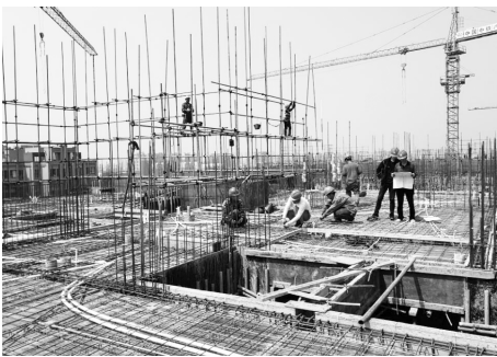
崇州永安安置房“五一”施工现场
