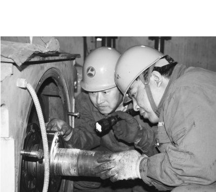
●沙河电厂职工对发电设备进行环保改造
