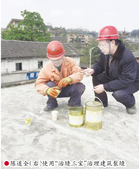
●陈道全(右)使用“治缝三宝”治理建筑裂缝
